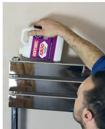
Pour une action curative, Sentinel préconise les désembouants à pH neutre X400 ou X800 avant d'ajouter en préventif un inhibiteur de corrosion. © Sentinel
