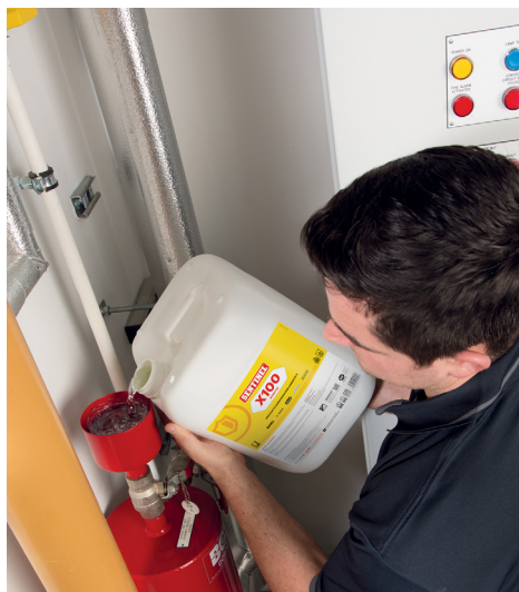
Ajout d'un inhibiteur de corrosion pour protéger l'installation et empêcher la formation de nouvelles boues.
